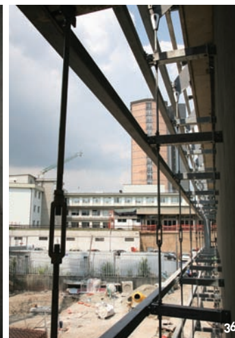
Figg. 29-30 – La struttura in acciaio a supporto della facciata vitrea (foto Cino Zucchi, foto di cantiere). Figg. 31-34 – Alcune fasi del montaggio della facciata vitrea sulla sottostruttura metallica (foto Cino Zucchi, foto di cantiere). Figg. 35-36 – I tiranti e i puntoni in acciaio della struttura di facciata (foto Cino Zucchi, foto di cantiere).
