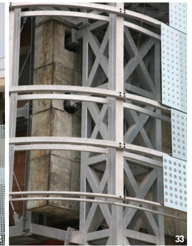
Figg. 29-30 – La struttura in acciaio a supporto della facciata vitrea (foto Cino Zucchi, foto di cantiere). Figg. 31-34 – Alcune fasi del montaggio della facciata vitrea sulla sottostruttura metallica (foto Cino Zucchi, foto di cantiere). Figg. 35-36 – I tiranti e i puntoni in acciaio della struttura di facciata (foto Cino Zucchi, foto di cantiere).
