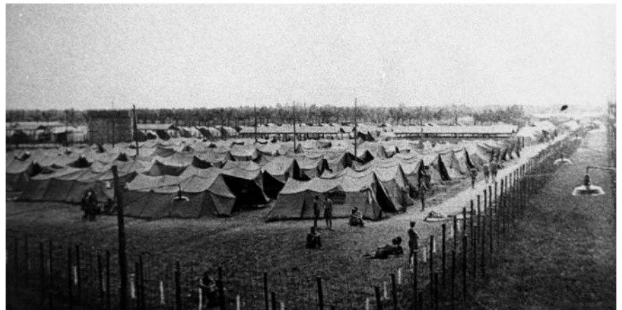
FIGURA 5 FOSSOLI. Campo Nuovo attendato, a metà del Campo si notano le tettoie di servizio e la struttura di sostegno per le vasche di raccolta dell'acqua (AN, Archivio Fotografico, Riproduzioni Centro Etnografico, foto n 25399b04)
