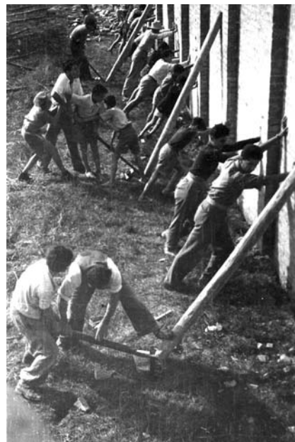
FIGURA 9 FOSSOLI. Campo Nuovo, Nomadelfia, demolizione del muro cinta (AN, Archivio Fotografico, Riproduzioni miste, 06692-S1)
