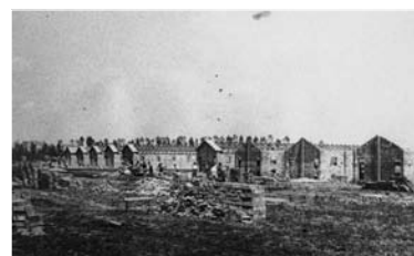
Campo Vecchio | costruzione
