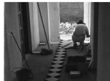
Nomadelfia | nuova pavimentazione
