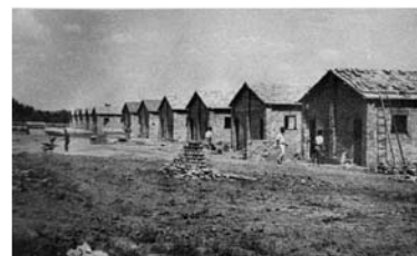
Campo Vecchio | costruzione
