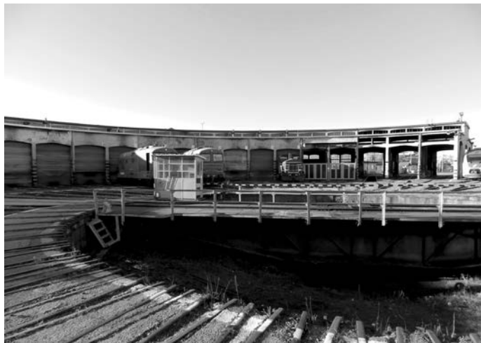
Deposito Locomotive, Torino. Prospetto esterno e interno della fabbrica.
