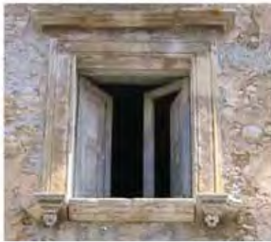
Fig. 2.05 Finestra, soglia a goccia in pietra calcarea: foto, schizzo e prospetto
