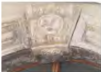
Fig. 2.06 Concio di chiave in pietra calcarea: foto, schizzo e prospetto
