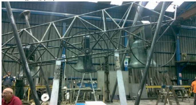
In questa pagina, dall'alto: Marco Dezzi Bardeschi, schizzi di progetto del campanile del Tempio Duomo a Pozzuoli; il cantiere del campanile con la struttura di supporto alle tre campane. Nella pagina a fianco: nuovo campanile del Tempio Duomo
