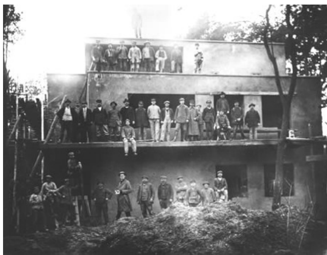
Cantiere di una casa doppia (fs, 1925)
