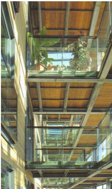
Sopra: Vista dei corridoi di distribuzione con struttura indipendente in acciaio e presenza, data l'ampiezza dei passaggi, di verde.
