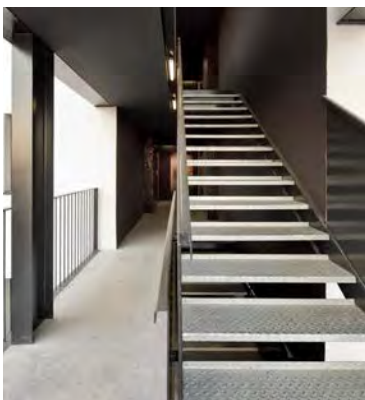
Sopra: Spazio connettivo verticale aperto all'esterno per incentivare la vita comunitaria
