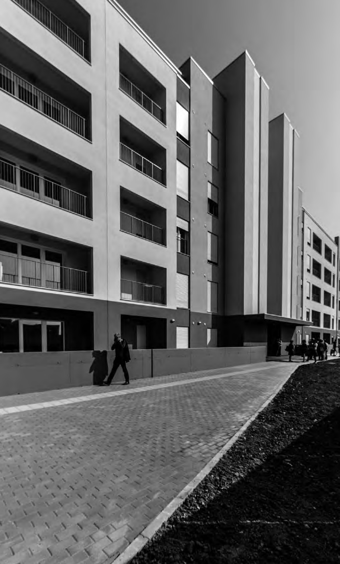
Fabbricato residenziale ERS ex Palaspecchi ora Corti di Medoro a Ferrara, n. 233 alloggi.
