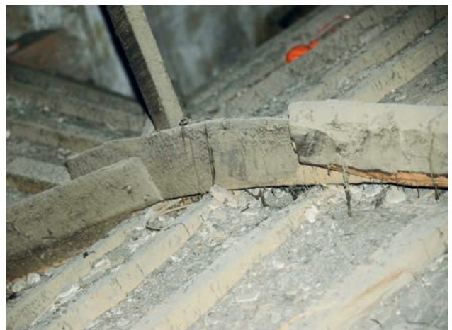
Al centro e sotto: FIGG. 4A-C Dettaglio della deformazione al centro dell'intradosso della volta e di porzioni dell'estradosso
