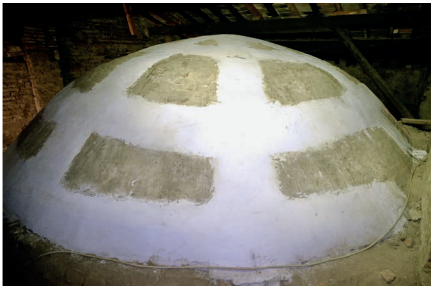
FIG. 7 La conclusione dei lavori di posa delle fibre di basalto con la "ricopertura" delle stesse con calce naturale identica a quella della muratura della cupola
