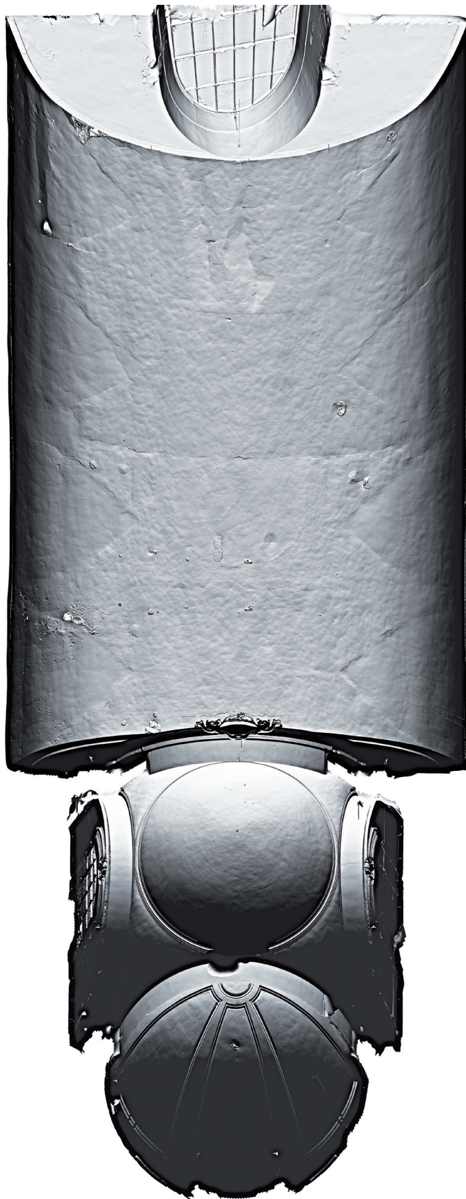
FIG. 7 Modello mesh della volta e della cupola. La vista della sola geometria evidenzia le irregolarità dell'intonaco dissimulate dalla pittura illusionistica. Sono chiaramente visibili ai lati della volta le tracce delle otto unghiate chiuse nel 1742
