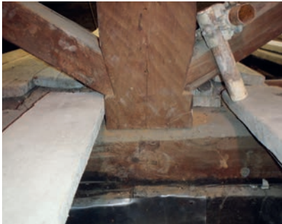
FIGG. 3A-C Particolare unione monaco-puntoni; particolare appoggio su muro: si noti l'unione catena puntone realizzata con dente semplice e mensola sottostante lavorata a intaglio. Non sono presenti staffature metalliche di presidio; particolare unione monaco saette
