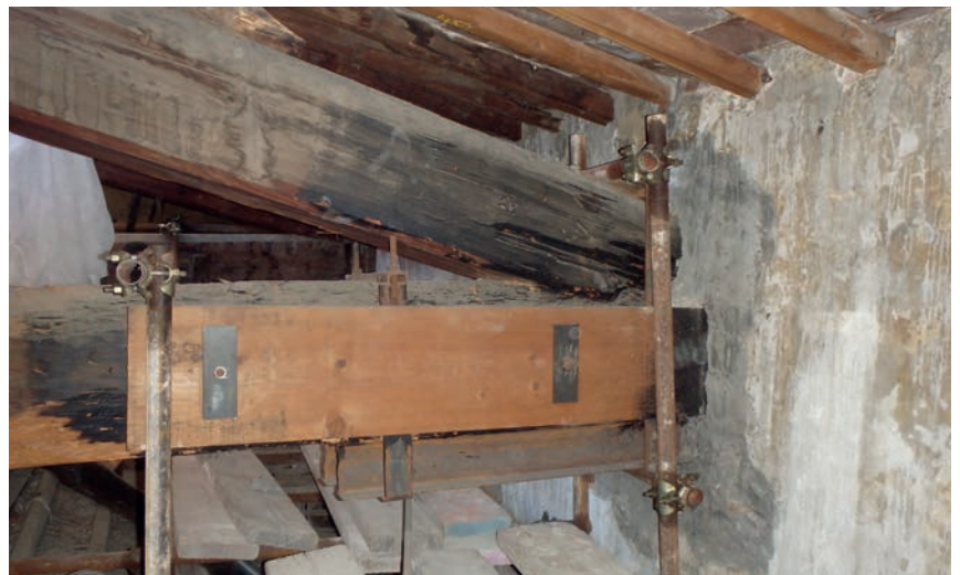
FIG. 6 Appoggio Sx della capriata C3 consolidato con coppia di putrelle in sostituzione della mensola lignea e guance laterali unite con bulloni metallici passanti
