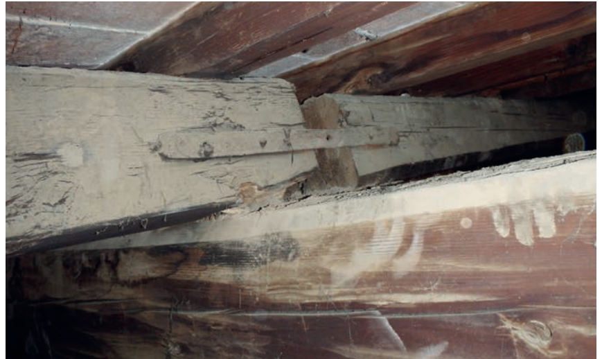
FIG. 4 Arcarecci attestati e uniti con staffa metallica chiodata e arpionata
