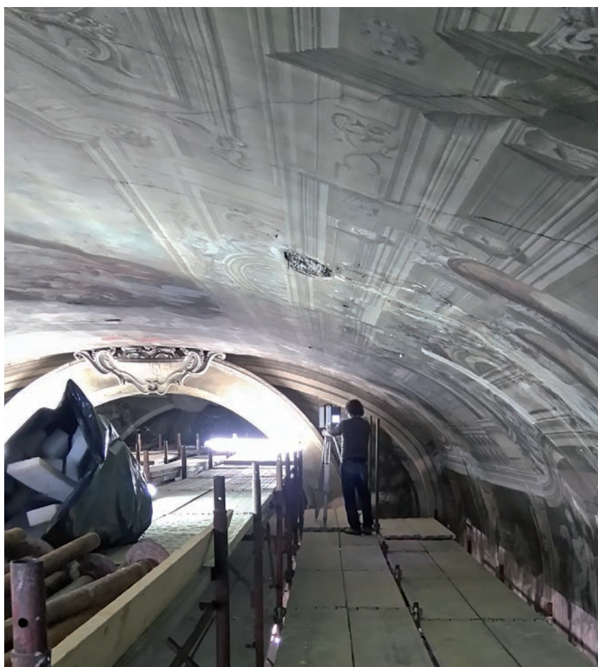
FIG. 4 Operazioni di campagna: acquisizioni con laser scanner
