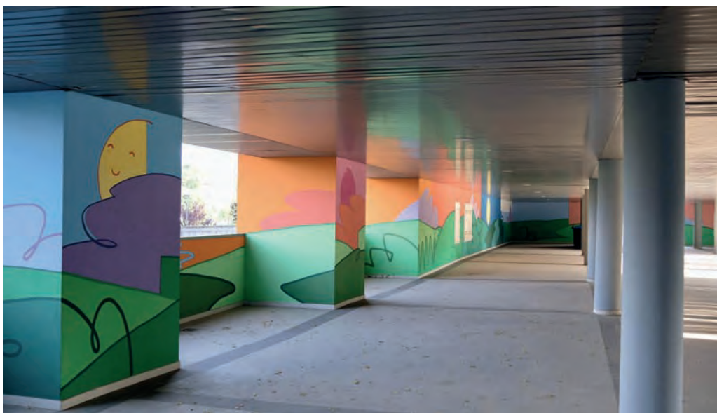
Piano pilotis con murales e corte interna di In Sala Community
