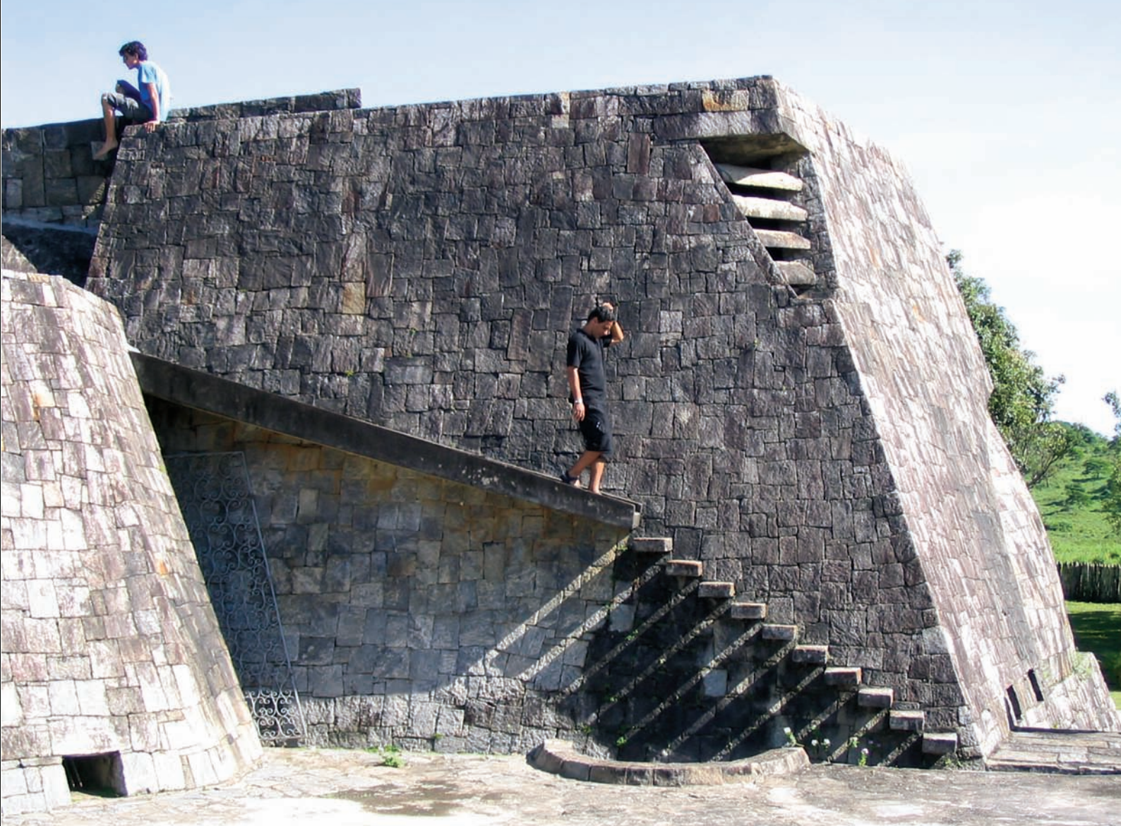
Veduta della facciata posteriore della Cappella, con la scala-grondaia di accesso alla copertura (foto dell'autore, marzo 2006)
