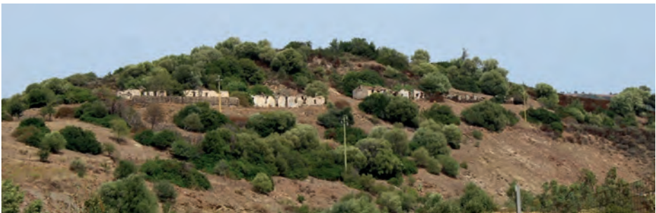
14. Vista generale sulle abitazioni degli operai a Lula (parte più alta del sito minerario).
