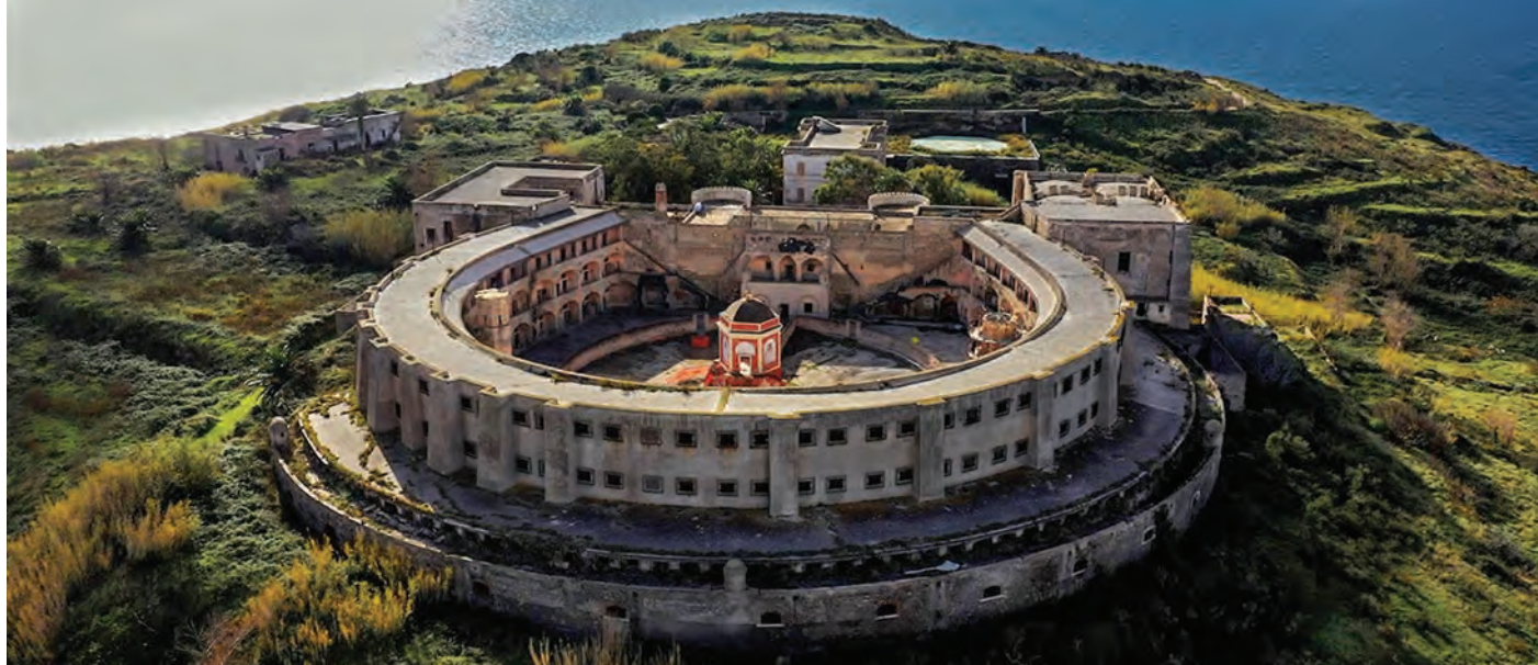
Sopra: Panoramica dell'isola di Santo Stefano e dell'ergastolo con la caratteristica forma di 'Panopticon'; sotto: interno dell'emiciclo delle celle, prima dell'avvio dei lavori di restauro
