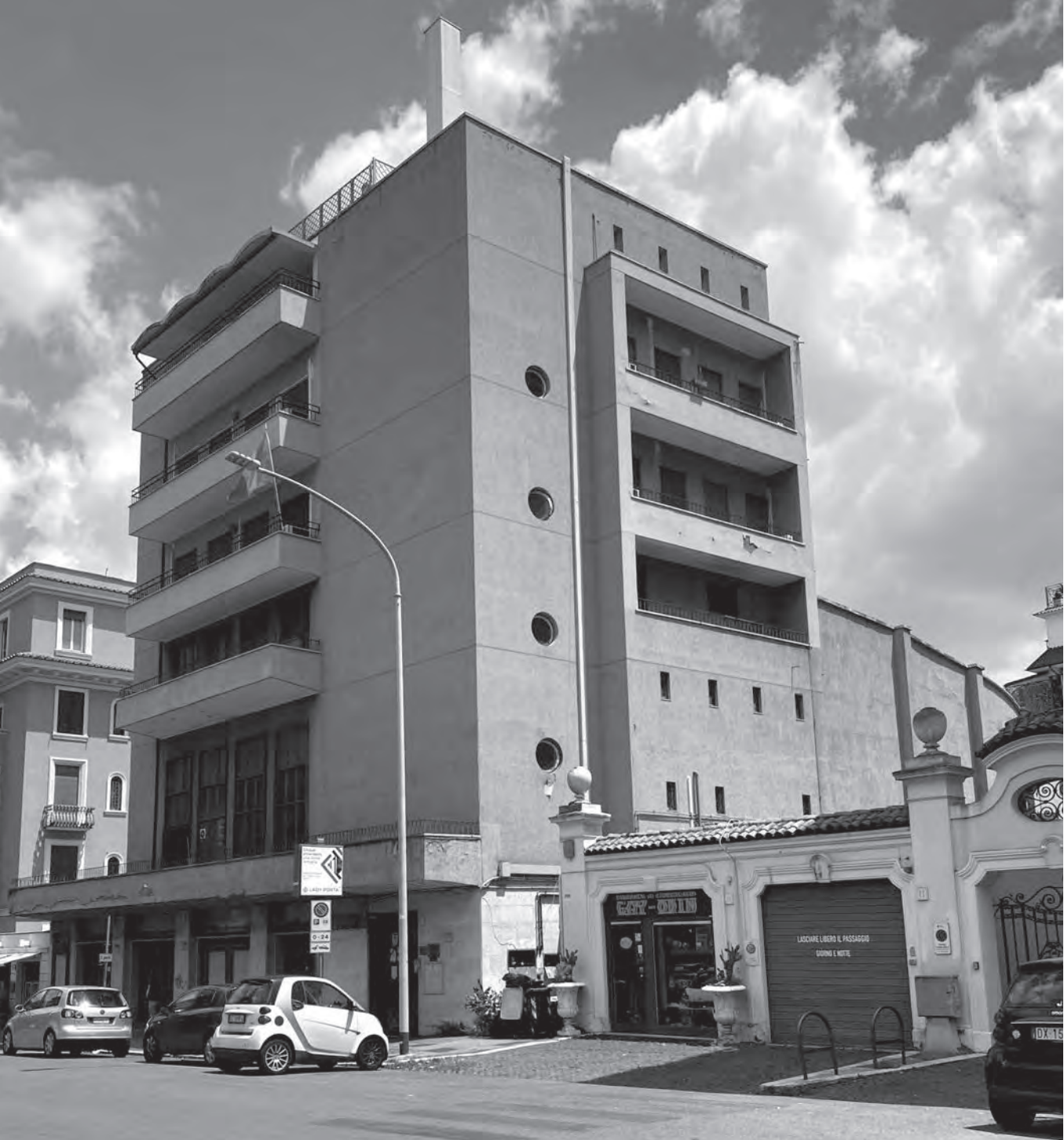
Roma. Nella pagina precedente: Sopra: Cinema Espero, dettaglio della scala; sotto: Cinema Astoria, atrio, 1946 (Archivio Morandi). In questa pagina: Cinema Astoria, oggi, veduta d'insieme e dettaglio dello stato di degrado (Archivio Morandi)
