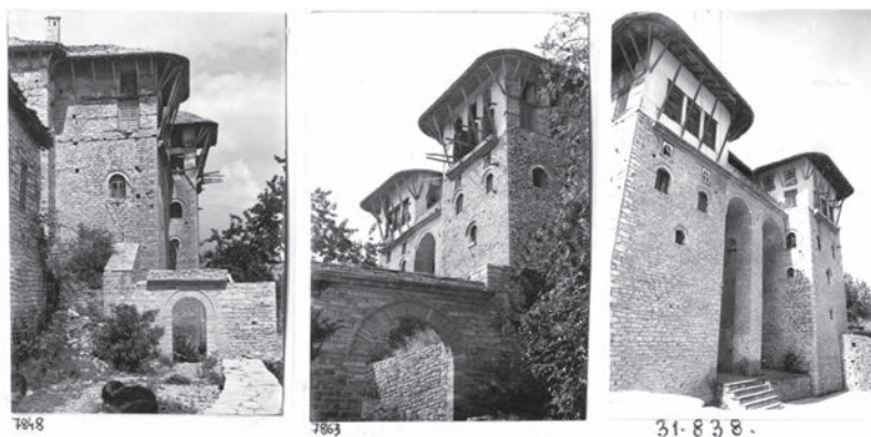
64. Banesa e Zekatëve, quartiere Palorto. Vedute dell'abitazione durante e dopo l'intervento di restauro degli anni Sessanta.
