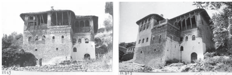
66. Banesa Ahmet Kikino, quartiere Manalat, Gjirokaštër. Vedute dell'abitazione prima e dopo l'intervento di restauro del 1970.
