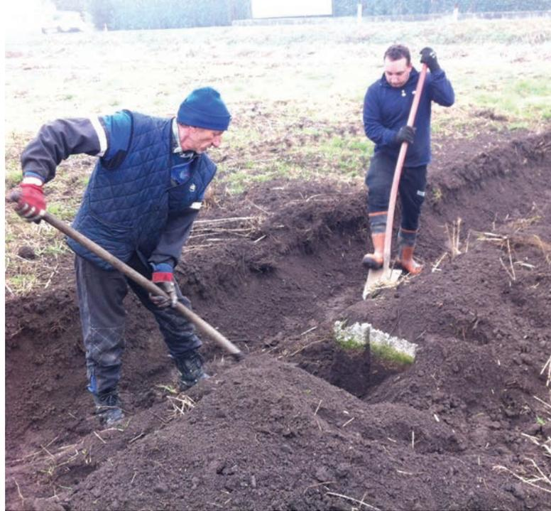
**2. Pulizia dei manufatti idraulici esistenti,** tramite la rimozione della vegetazione e della terra che li ricopre. Come nel restauro di un giardino storico, tale operazione è preliminare al rilievo metrico-geometrico della marcita. (sopra)
