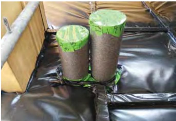
FIG.14 | NASTRO A TENUTA APPLICATO SUI CANALI DI USCITA DELLA VENTILAZIONE MECCANICA CONTROLLATA (LATO INTERNO)
