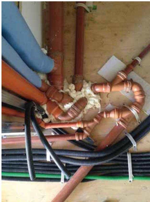
FIG.16 SCHIUME POLIURETANICHE APPLICATE NEL FORO DI ATTRAVERSAMENTO DEL PANNELLO IN CLT DEL SOLAIO INTERPIANO PER GARANTIRE UNA BUONA TENUTA ALL'ARIA TRA I DIVERSI APPARTAMENTI Il requisito sarà ulteriormente migliorato dalla successiva posa del sottofondo alleggerito e del massetto cementizio che ricopriranno integralmente gli impianti
