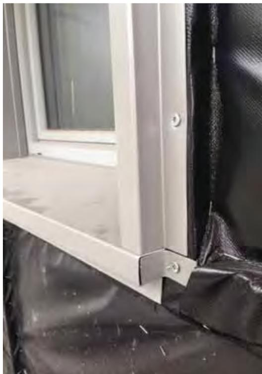
FIG.36 | INSTALLAZIONE DELL'IMBOTTE IN LAMIERA DI ALLUMINIO VERNICIATA
