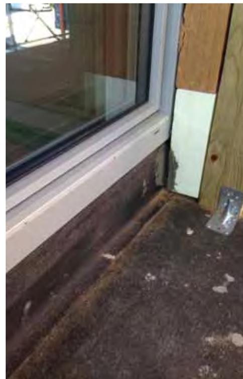
FIG.37 | ATTACCO INFERIORE DELLA PORTAFINESTRA SU DI UN ELEMENTO IN LEGNO DI LARICE PROTETTO DA UNA MEMBRANA IMPERMEABILIZZANTE
