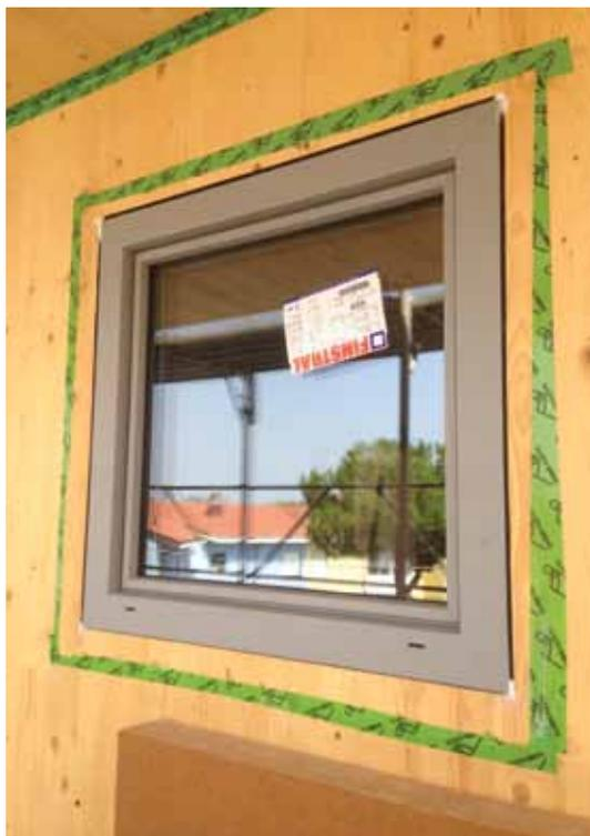
FIG.35 | INSTALLAZIONE DELLA FINESTRA DIRETTAMENTE NEL PANNELLO IN CLT SENZA L'IMPIEGO DEL FALSO TELAIO
