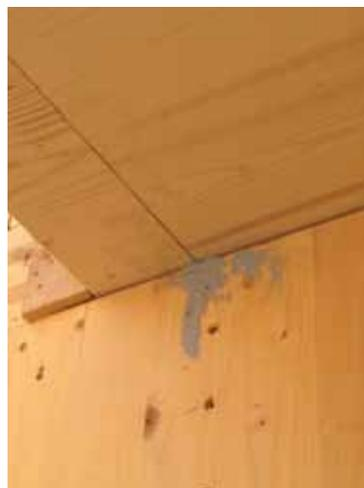
FIG.6 | NASTRATURA IN PRESENZA DI PIASTRA DI ANCORAGGIO CON FORI PASSANTI E TRAVE IN LEGNO AGGETTANTE
