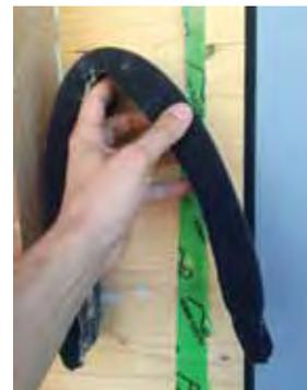
FIG.10 | POSA DELL'INFISSO CON NASTRO BUTILICO ESPANDENTE
