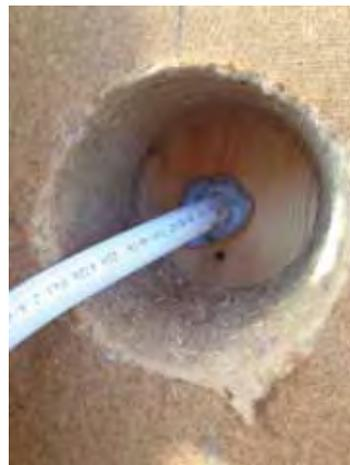
FIG.12 | INIEZIONE DI COLLE SILICONICHE NEL FORO DI ATTRAVERSAMENTO DI UN TUBO DELL'ACQUA (LATO ESTERNO)
