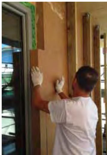
FIG.31 | L'ISOLAMENTO TERMICO RICOPRE IL TELAIO DELL'INFISSO PER LIMITARNE LE DISPERSIONI
