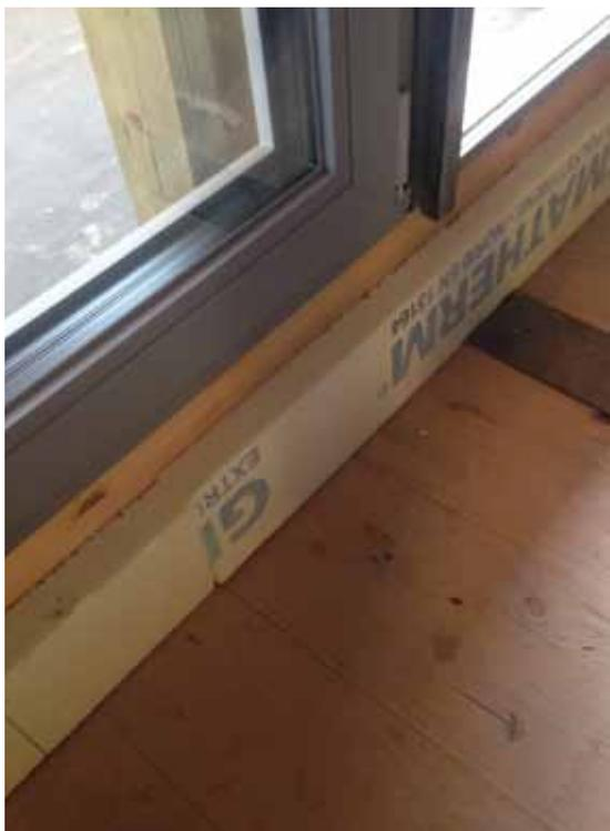
FIG.38 | ATTACCO INFERIORE DELLA PORTAFINESTRA VISTO DAL LATO INTERNO, DOVE È STATO INSERITO UN PANNELLO DI XPS DI ALTEZZA 12CM PARI ALLO SPESSORE DEL SOTTOFONDO
