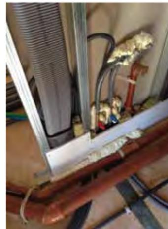
FIG.13 | INIEZIONE DI SCHIUME POLIURETANICHE NEI FORI DI ATTRAVERSAMENTO DI TUBI DELL'ACQUA (LATO INTERNO)
