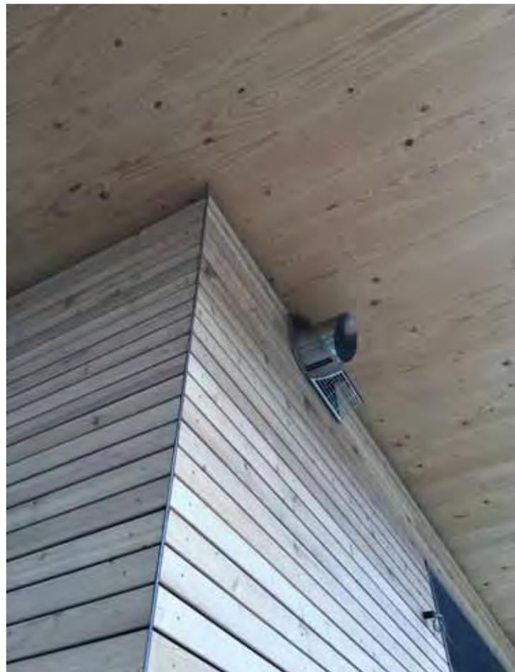
FIG.28 | SOLUZIONE D'ANGOLO CON RIVESTIMENTO IN TAVOLE DI LARICE
