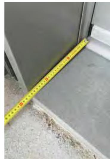
FIG.39 | ATTACCO INFERIORE DELLA PORTAFINESTRA DOVE È STATO INSTALLATO L'ISOLANTE IN XPS PER LA PROTEZIONE DEL PONTE TERMICO DELLA SOGLIA IN PIETRA
