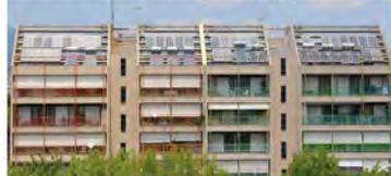
Esterno: pannelli fotovoltaici e solari termici in copertura sugli edifici a blocco.
