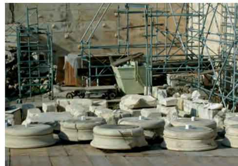
*Particolari del cantiere nella fase di identificazione dei frammenti sparsi, di anastilosi e ricostruzione delle parti mancanti*
