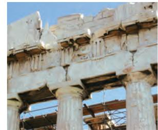
*Il restauro del Partenone nella fase di sostituzione dei completamenti siderocementizi con opere in marmo pentelico*
