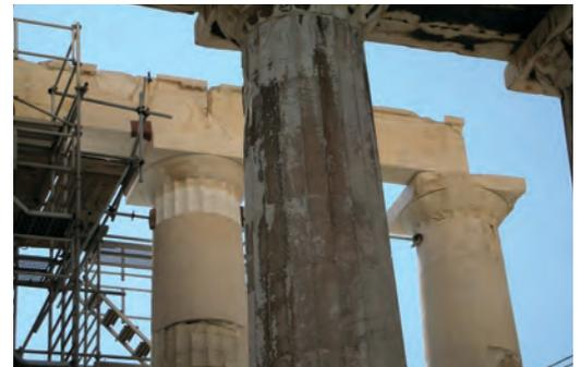
*Ricomposizione e integrazione delle lacune e degli elementi fratturati con barre di titanio, cemento bianco e marmo pentelico*
